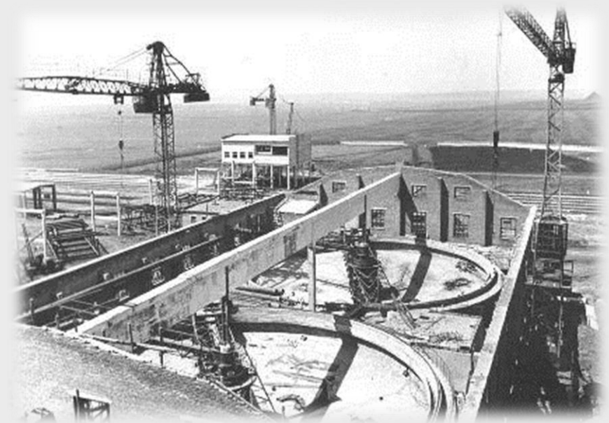
Комплекс Шолоховской ЦОФ. 1962 год. Возведение цеха радиальных сгустителей. В здании видны уникальные конусные емкости радиальных сгустителей.
